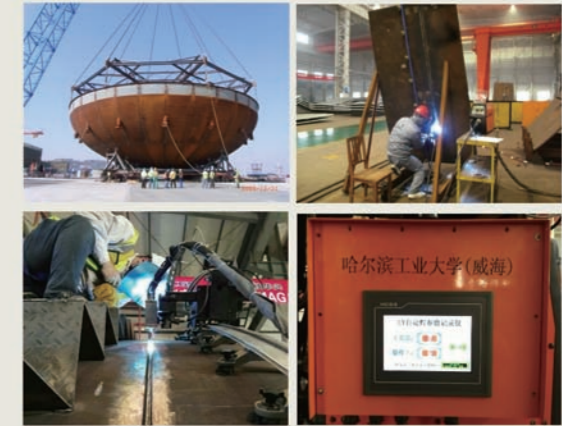
AP1000/CAP1400核电CV安全壳自动化焊接
