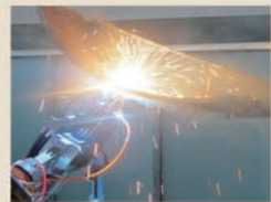
管道全位置激光电弧复合焊接
